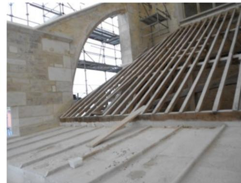
La toiture du bas - côté sera refaite en ardoises, celle des chapelles en plomb et les eaux pluviales
